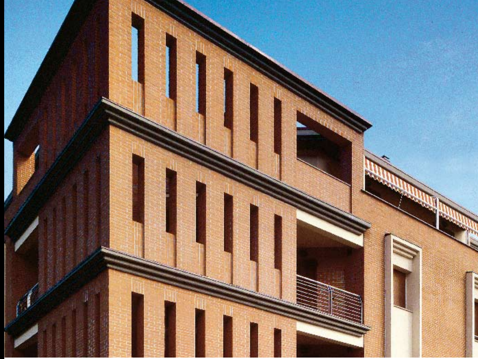
Complesso residenziale Montelupo Fiorentino, Firenze - CLASSICO SABBIA FINE
